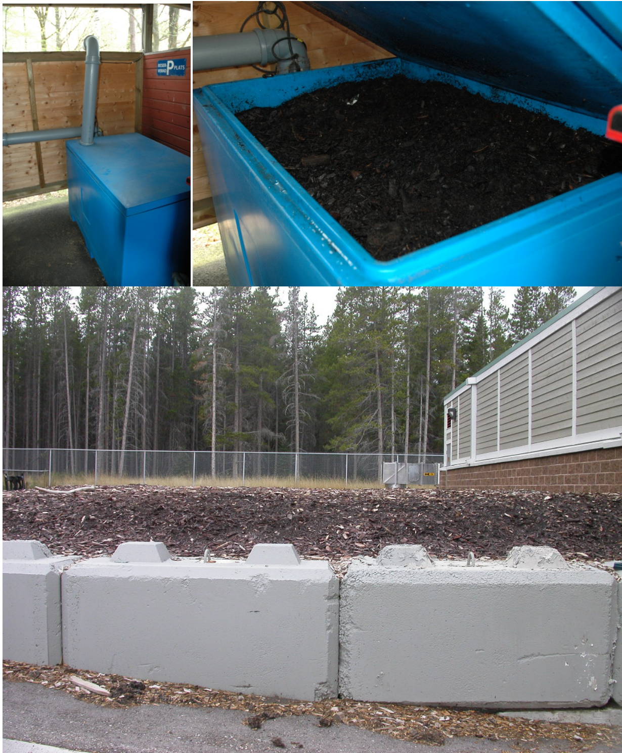
Figure 83: Différents biofiltres utilisés dans (a et b) des systèmes d'échelle intermédiaire ou (c) à grande échelle (photos Louise Hénault-Ethier).
