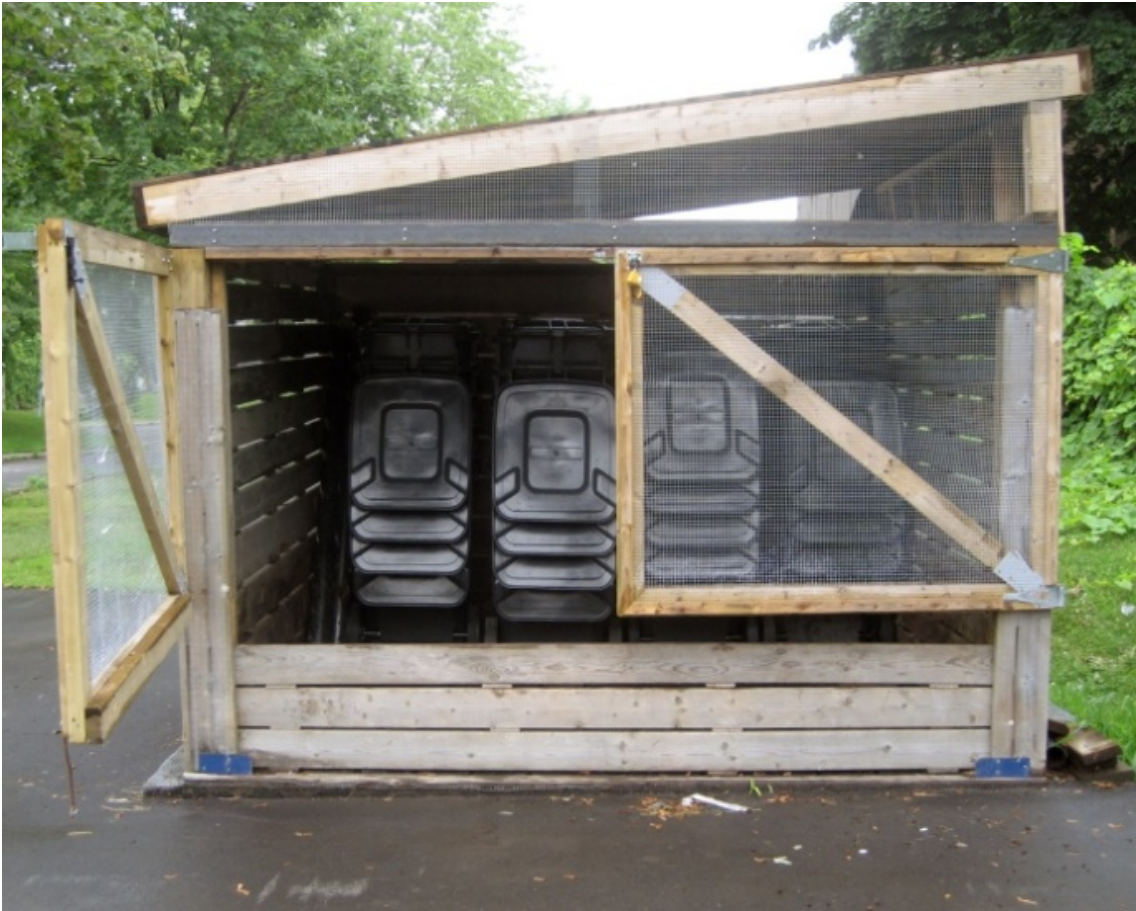
Figure 41: Entrepôt pour les bacs de collecte pleins ou vides et propres (photo Louise Hénault-Ethier).
