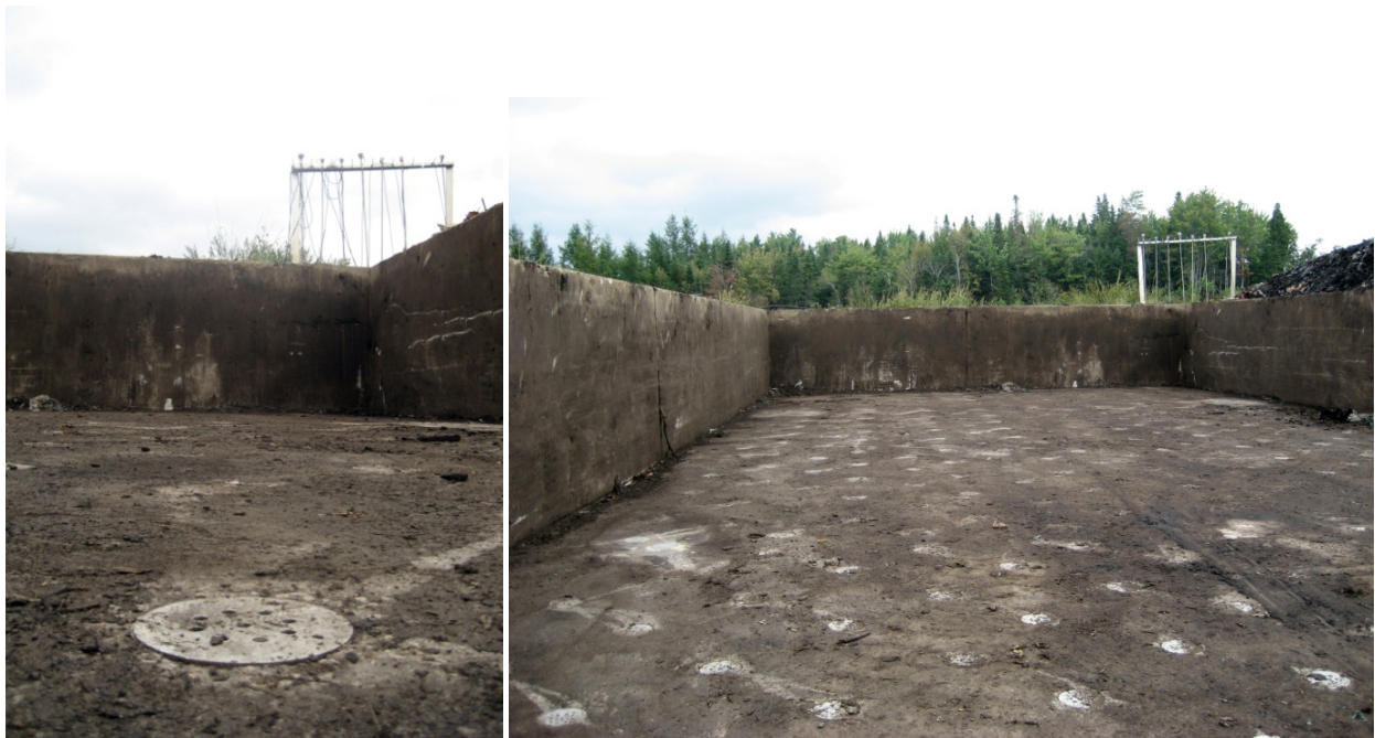
Figure 16: Les piles statiques aérées, aussi appelées piles statiques sous aération forcée. En a) on voit le détail d'une sortie d'aération et en b) on voit l'ensemble de la baie où se fait le compostage sous pile statique aérée.
