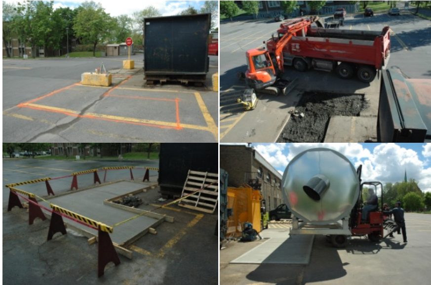
Figure 48: Étapes de construction d'une dalle de béton armé en construction pour accueillir un bio-réacteur et un élévateur hydraulique: (a) marquage, (b) creusage, (c) coulage du béton sur l'armature et (d) dalle prête à recevoir la charge (photos Alexis Fortin).
