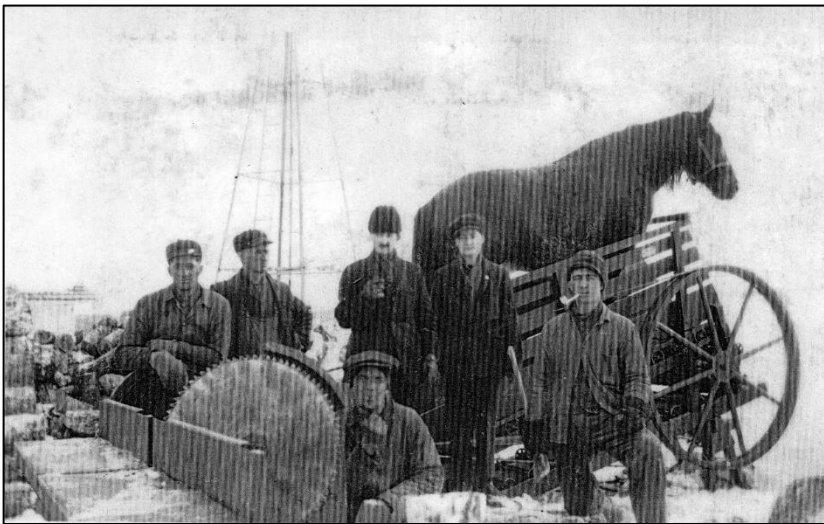
Source : Scie mue par cheval chez Ernest Breton, Yvette Breton-Maheux St-Frederic, Société du patrimoine des Beaucerons.
